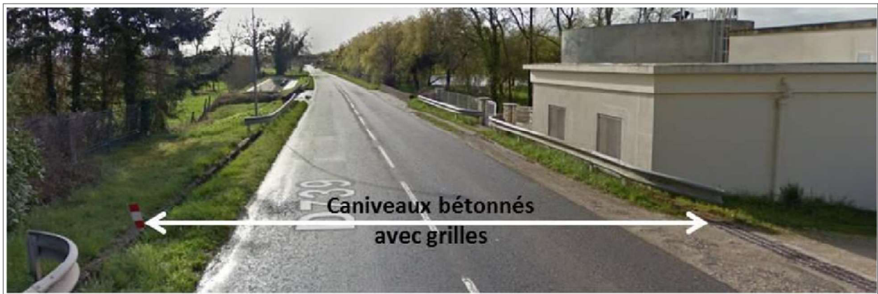
Figure 16 : Glissières de sécurité et caniveaux bétonnés le long de la route départementale au droit du site de Basse Terne (document TERRAQUA)
